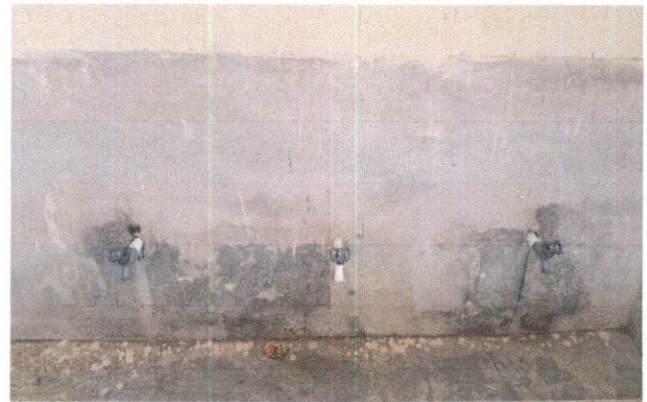
Foto 4: REMOZAMIENTO DE LAVAMANOS
