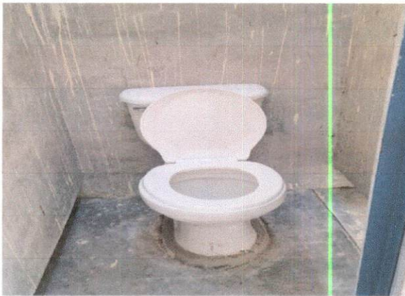
Foto 3: CAMBIO DE SANITARIOS
